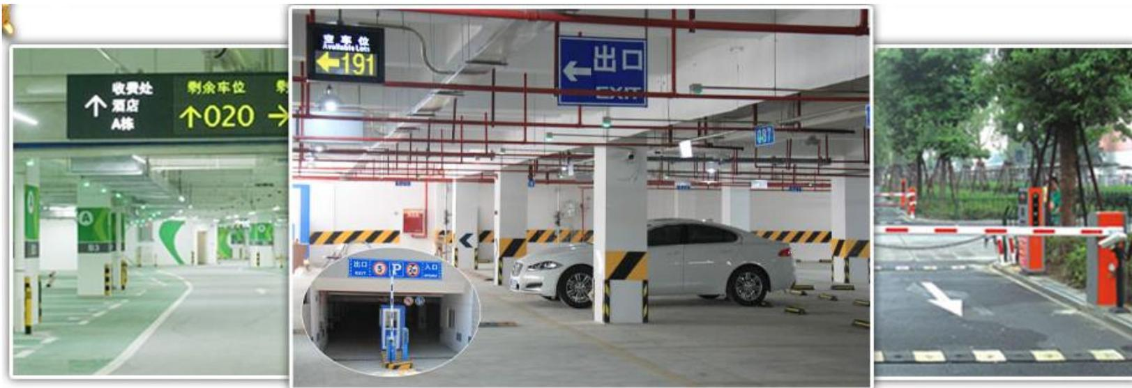
**车位引导系统**是指停车场引导车辆停入空车位的智能泊车引导系统，由智能电脑系统对车位进行检测，通过显示屏显示空车位信息，司机通过该信息，实现轻松停车，并通过终端机查询实现自动寻车。
